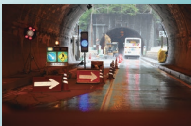
共同溝、洞道、工事現場
